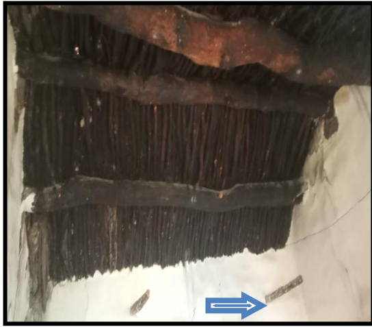
الصورة 4 أعمد النسيج
